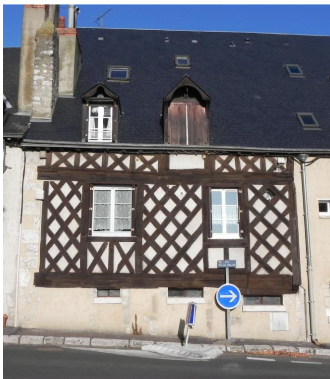
Une maison en pans de bois située en Vienne au 26 rue de la chaîne à Blois .
